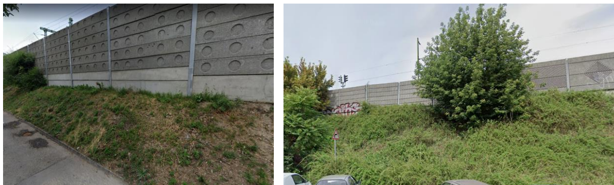
4.4. ábra: Vasúti zajvédő fal a Kővirág soron és a Dombóvári út mentén
